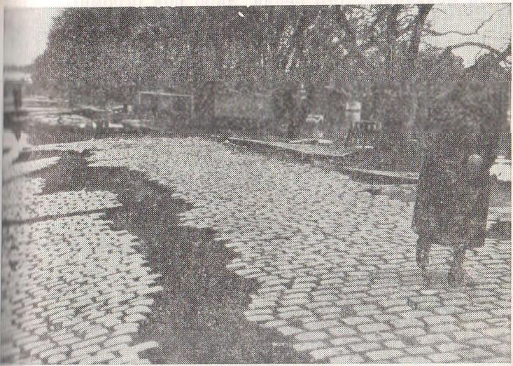
Фотография трещины после землетрясения в Вальдивии (1960)
